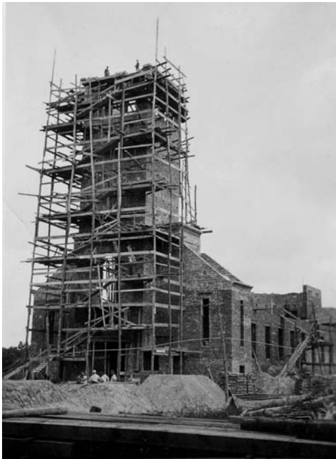
4 pav. Šv. Antano bažnyčios bokšto statyba 1936 m.
