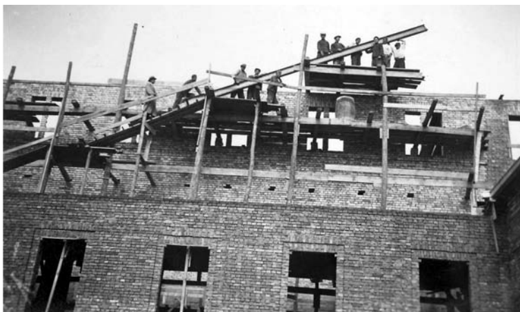
3 pav. Keliama valcuotojo plieno sija ant Šv. Antano bažnyčios denginio 1936 m. Fig. 3. Rolling of the steel beam onto the roof of St. Antonius church in 1936
